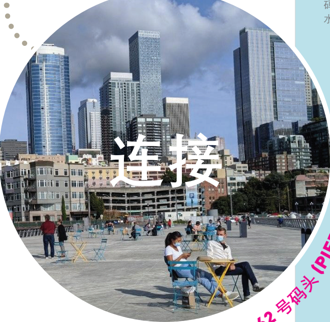
15 第 62 号码头 (PIER 62) 重建
